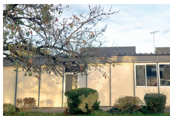
SALLE « ANCIENNE CANTINE »
